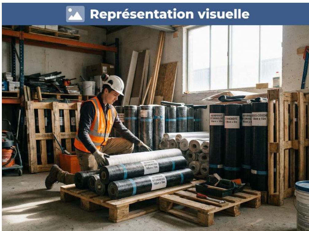
Commande de rouleaux avec 5% de marge pour coupes et chutes
