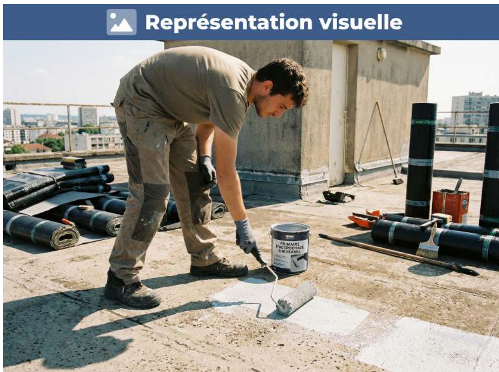
Application de primaire à 0,2-0,4 L/m 2 , temps de séchage 30 à 60 minutes
